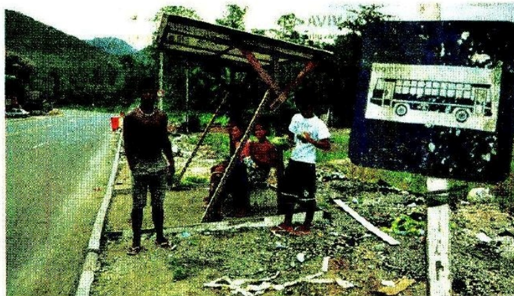
Traves de madeira sustentam teto no ponto de ônibus
